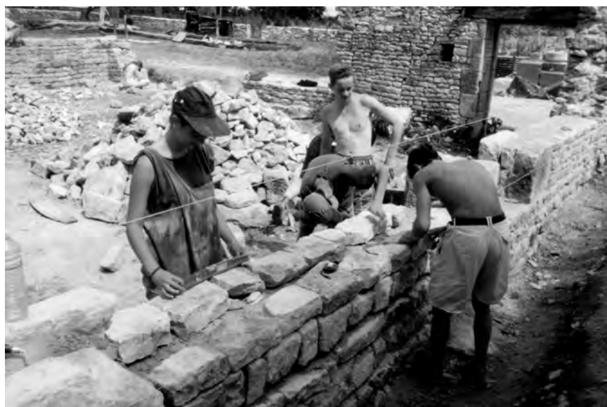
Construction d'un mur. Activité pédagogique - Collection Club Marpen
